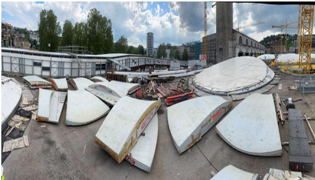
Abbildung 8 Schalungselemente des neuen Tiefbahnhofs Stuttgart 21 finden Wiederverwendung im Jugendtreff Ingersheim <sup>8</sup>
