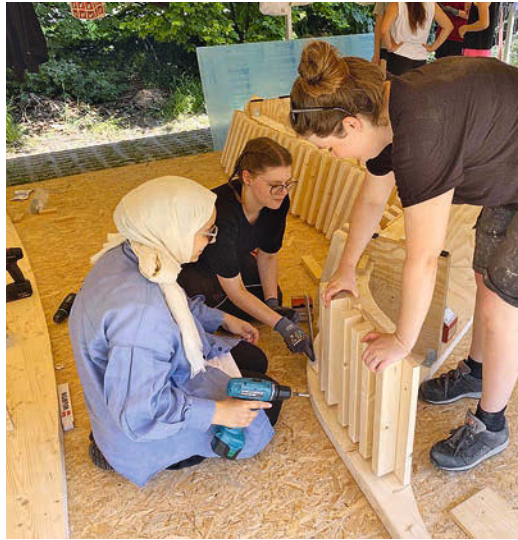
In einem Workshop vor Ort veredelten Studierende die Oberflächen der Schalungselemente und bauten fehlende Passtücke. • In an on-site workshop, students refined the formwork elements and built missing fitting pieces.
