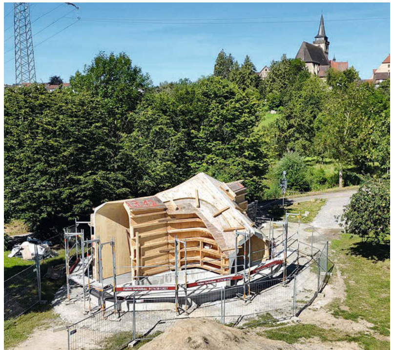
Der Pavillon im Bau – noch ohne Außenhülle • The pavilion under construction - still without an outer shell
