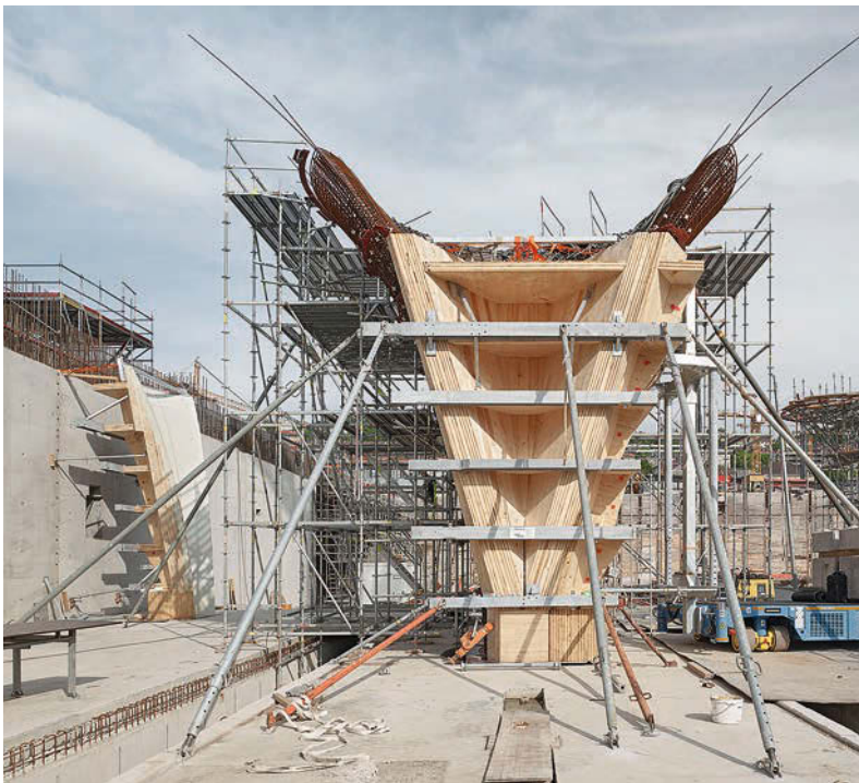
Schalungselement auf der Baustelle von Stuttgart 21 • Formwork element on the Stuttgart 21 construction site
