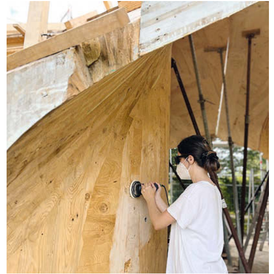
In einem Workshop vor Ort veredelten Studierende die Oberflächen der Schalungselemente und bauten fehlende Passtücke. • In an on-site workshop, students refined the formwork elements and built missing fitting pieces.
